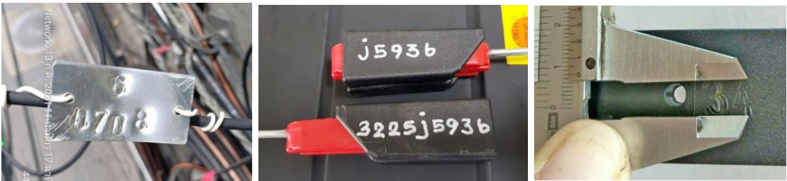
ภาพประกอบที่ 20. กำกับ Port Number อักษร “J” บนอุปกรณ์จับยึดฯ (Nylon-6) 2
